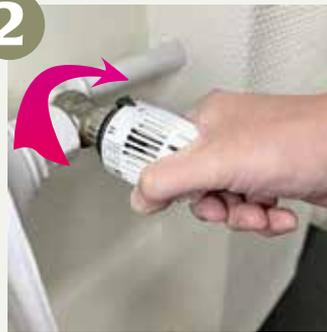
Stellen Sie zum Entlüften der Heizung das Thermostatventil des Heizkörpers auf null. Auf der anderen Seite der Heizung befindet sich das kleine Ventil, über das Sie die Heizung entlüften können.
