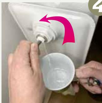
Setzen Sie den Vierkantschlüssel auf die Schraube, halten Sie das Gefäß darunter und drehen Sie die Schraube langsam und vorsichtig ein wenig auf. Nun kann die eingeschlossene Luft entweichen. Sobald in einem durchgängigen dünnen Strahl Wasser (*Achtung, könnte sehr heiß sein!*) aus
