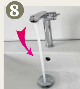
Um zu **prüfen**, ob alles **dicht** ist, trocknen Sie alle Teile sorgfältig ab, öffnen den Wasserhahn und lassen das Wasser eine Zeitlang laufen. Ob es an keiner Stelle tropft, prüfen Sie am besten mit **trockenen Fingern**!
