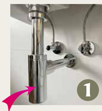
Dies ist ein **Siphon** am Waschbecken. Er kann auch aus Kunststoff gefertigt sein oder aus einem gebogenen Metallrohr bestehen. Das Prinzip ist aber überall gleich.
