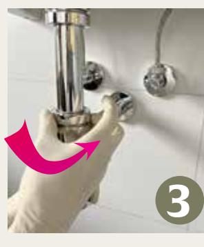
Lösen Sie nun den oberen **Befestigungsring** des Siphons, indem Sie ihn mit der Hand gegen den Uhrzeigersinn (von unten betrachtet) aufschrauben.
