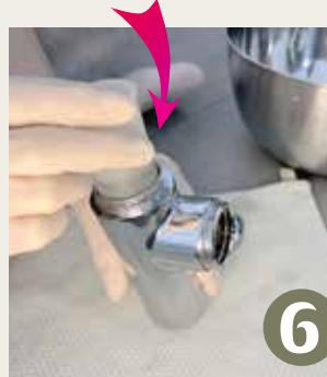
Setzen Sie den gesäuberten Siphon **in umgekehrter Reihenfolge** wieder zusammen. Wichtig ist, dass alle Dichtungsringe an der richtigen Stelle sitzen, damit es später nirgends tropft!
