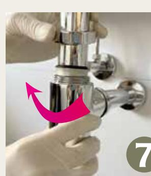
Schieben Sie den Siphon schließlich wieder so weit in die Wand, bis er unter dem Abflussrohr steht und schrauben Sie den oberen Befestigungsring im Uhrzeigersinn mit der Hand fest. Ist alles befestigt, können Sie die Rosette an die Wand schieben.
