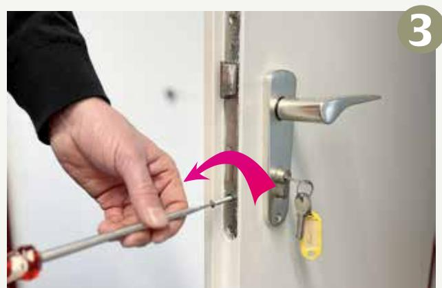
Drehen Sie die Schraube mit einem Schraubendreher komplett heraus. Hinweis: Die Schraube ist lang, Sie müssen also eine ganze Weile drehen! Ziehen Sie die Schraube dann ganz hinaus.
