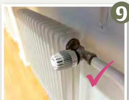
Setzen Sie nun den Thermostatkopf auf **Stellung „5“** wieder auf das Rohr auf.
