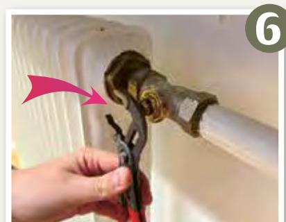
Ist das Thermostat locker, drehen Sie am einfachsten **mit der Hand** weiter.
