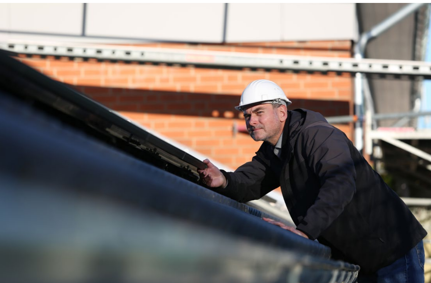
Neues Dach und Photovoltaikanlage in der Bergiusstraße 25–37 B.
